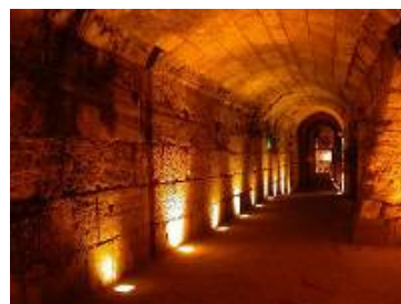
Tunel Zapadnog zida
